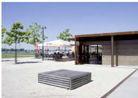
Référence (Hard, Autriche) : aménagement urbain des rives, lieu de rencontre dans le secteur du port. (image cafeamsee)
