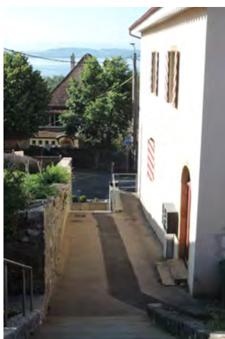
L'escalier de la gare CFF en balcon sur le lac.
