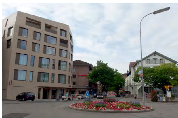
Références (Berthoud) : Bâtiment repère avec un rapport clair à l'espace-rue. (image vdw)
