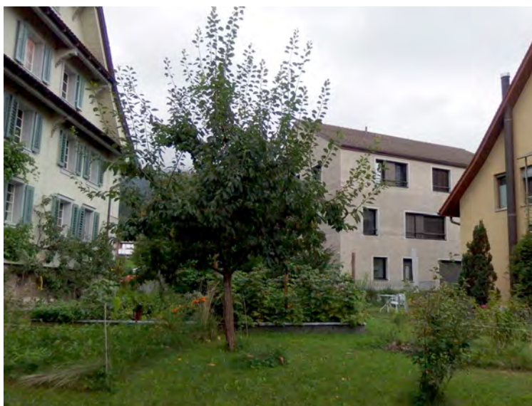
Référence (Oberwil) : le nouveau bâtiment s'intègre dans son environnement grâce à son implantation, son langage architectural et le traitement des espaces ouverts. (image vdw)
