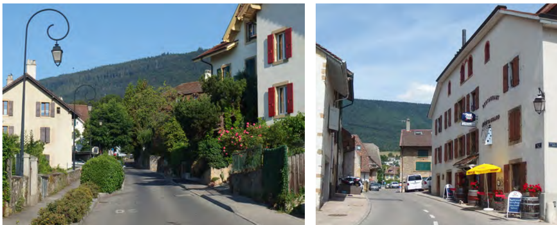
A gauche, la route des Lavannes avec son bâti ponctuel et ses jardins et à droite, l'ancienne localité avec ses fronts bâtis et son espace-rue minéral comme deux quartiers distincts.
