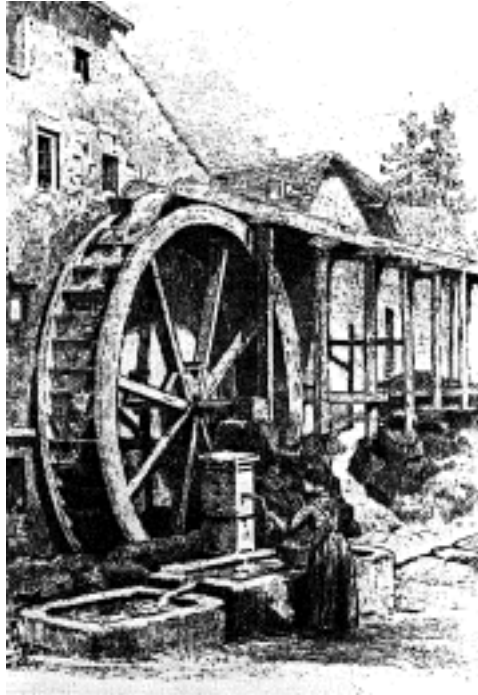
Fig. 19 Le moulin du haut vers 1900. Eau-forte de Gustave de Steiger.
