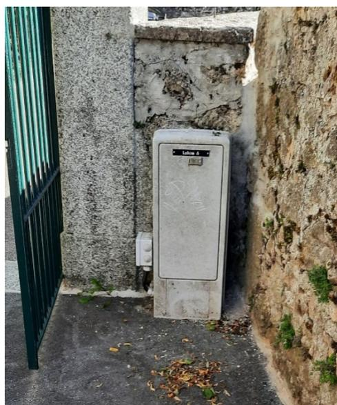
Cette armoire n'est pas équipée de réglettes avec fusibles permettant de protéger les bâtiments alimentés. Ainsi s'il devait y avoir un défaut sur un câble, tous les consommateurs reliés à cette armoire seraient coupés. Il est par conséquent prévu d'installer une armoire équipée de réglettes avec fusibles. Les câbles d'éclairage public seront également intégrés à l'armoire (actuellement boîte de dérivation sur le côté de l'armoire).
