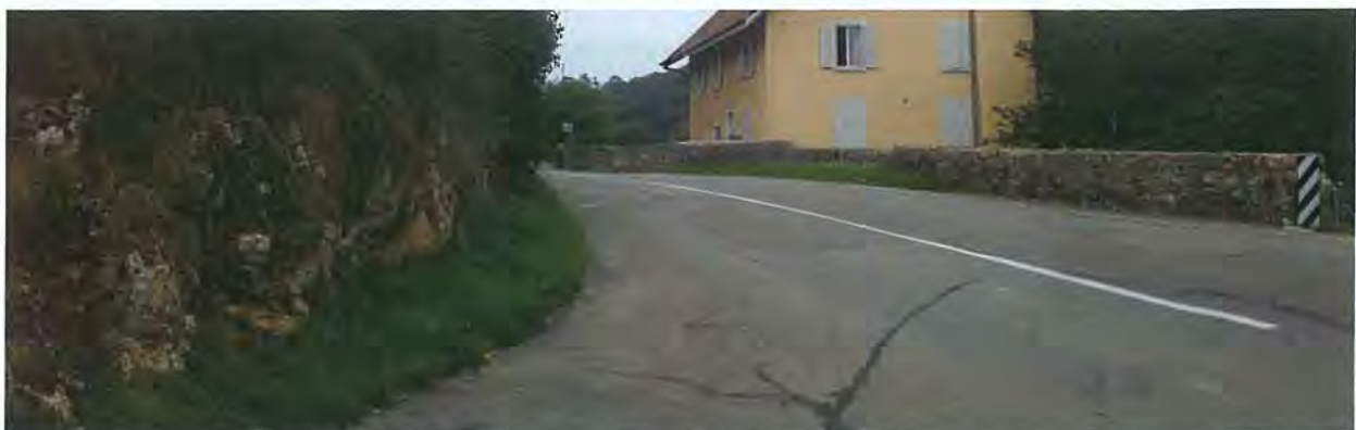
Photo 1 : Champ de visibilité depuis le débouché des Rochettes direction Lignièrès (distance d'observation de 2.5m et distance de visibilité de 41m)
