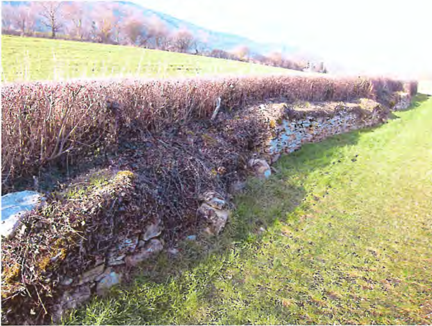
Figure 36 : Partie est de la haie 6 et du mur 7
