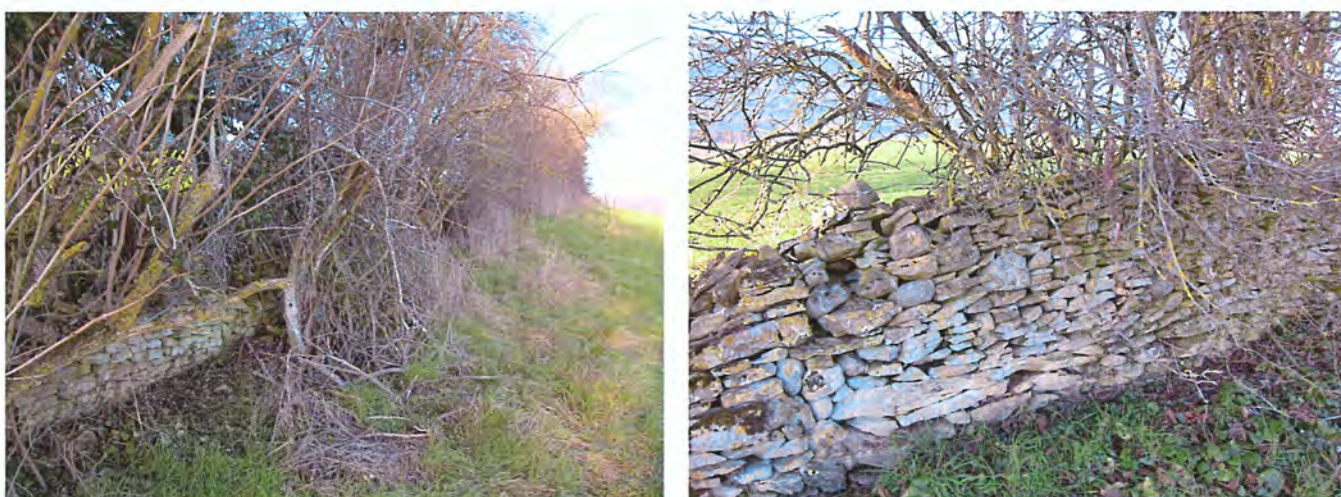
Figure 5 : Mur 4, situé dans la haie 3, comprenant des tronçons construits hauts
